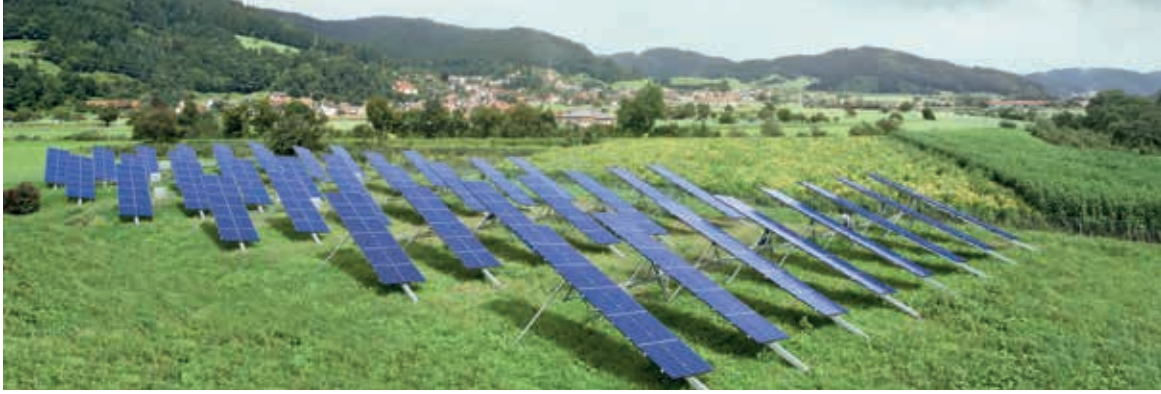
Rheinau tesisi. 28 adet kompakt ve kurulumu kolay SunCarrier 22 takip sistemi her sene 135.000 kWh elektrik üretiyor.
